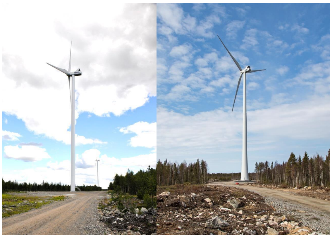
Bild 5.2. Till vänster ett exempel på ett cylindertorn och till höger ett hybridtorn. (Bilder: Leila Väyrynen och Ville Suorsa, FCG)
