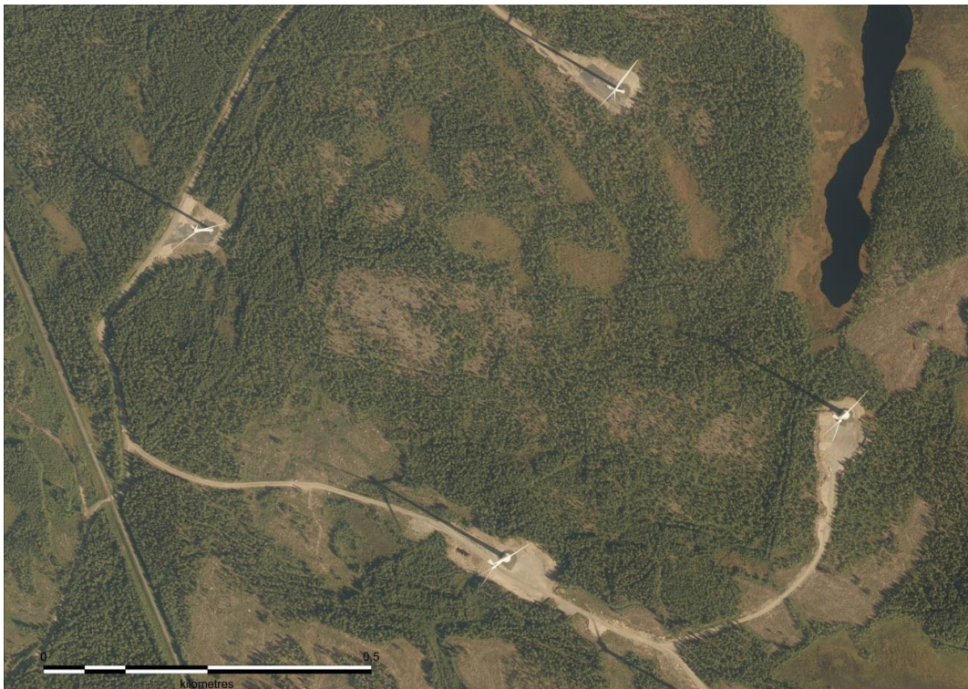
Bild 5.1. På flygbildsexemplet syns vindkraftverk som är i drift. Servicevägar och resningsfält har byggts för vindkraftverken. I omgivningen av vindkraftverken och mellan dem har den tidigare markanvändningen bevarats oförändrad.
