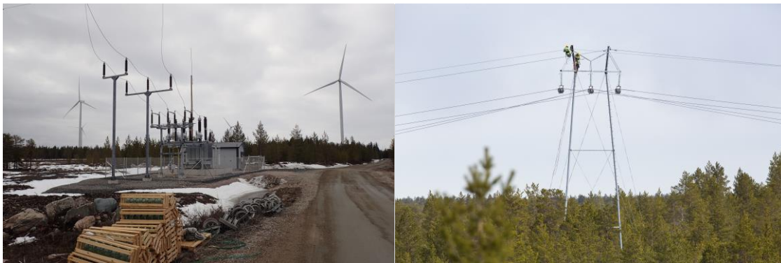
Bildpar 5.14. Byggande av elstationen och kraftledningen. (Bilder: Ville Suorsa, FCG)
