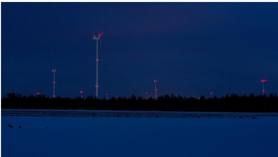
Bild 5.4. Fasta röda flyghinderljus. (Bild: Ville Suorsa, FCG)
