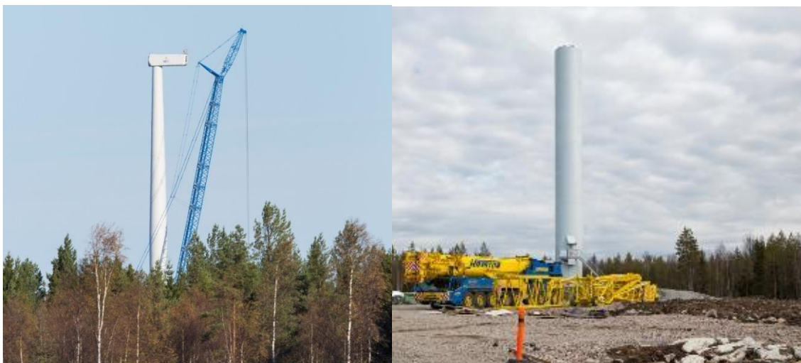
Bildpar 5.12. Montering av vindkraftverk. (Bilder: Ville Suorsa, FCG)
