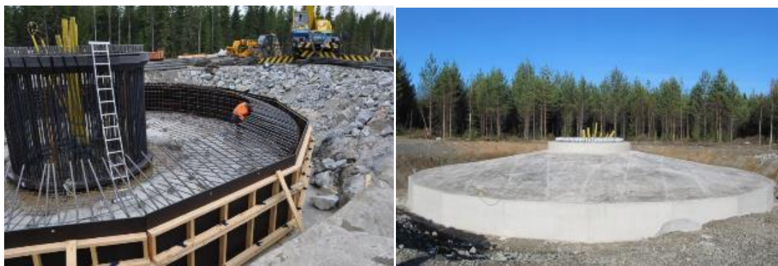
Bildpar 5.11. Byggande av vindkraftverkens fundament. (Bilder: Leila Väyrynen, FCG)
