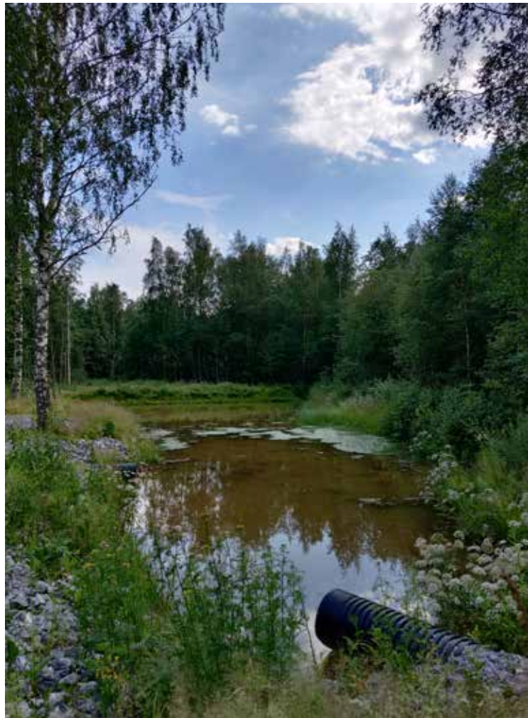
Tehtaankadun sadevesiallas Pietarsaassa on suunniteltu estämään tulvat rankkasateiden sattuessa.
