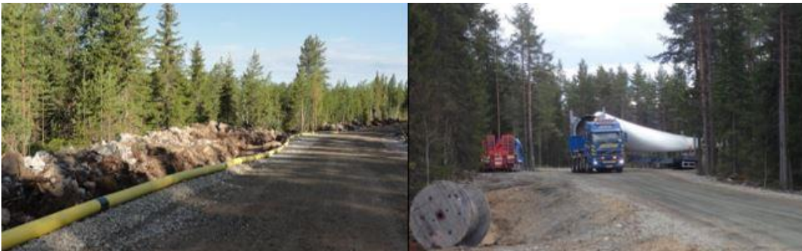
Bild 86. Till vänster ett exempel på byggnads- och servicevägar i vindkraftsparken. Vägarna används bland annat för transport av betong, grus och kraftverkskomponenter samt för servicekörningar i vindkraftsparkens driftsskede. Jordkabeln placeras i ett dikesschakt i kanten av vägen. Till höger delar till vindkraftverk som transporteras som specialtransporter. (Ville Suorsa, FCG)
