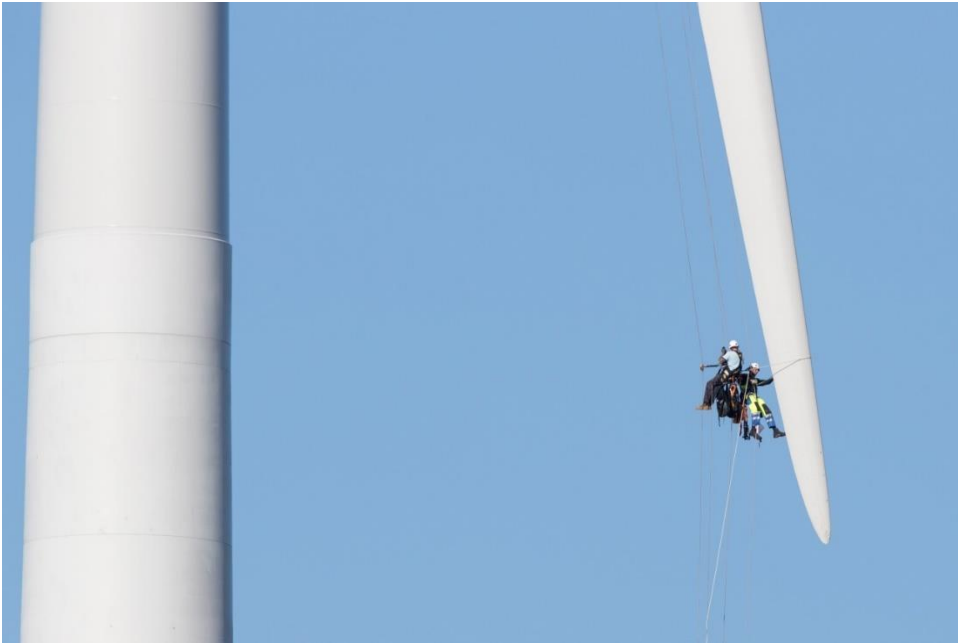
Bild 92. Underhåll av vindkraftverk (Ville Suorsa, FCG).
