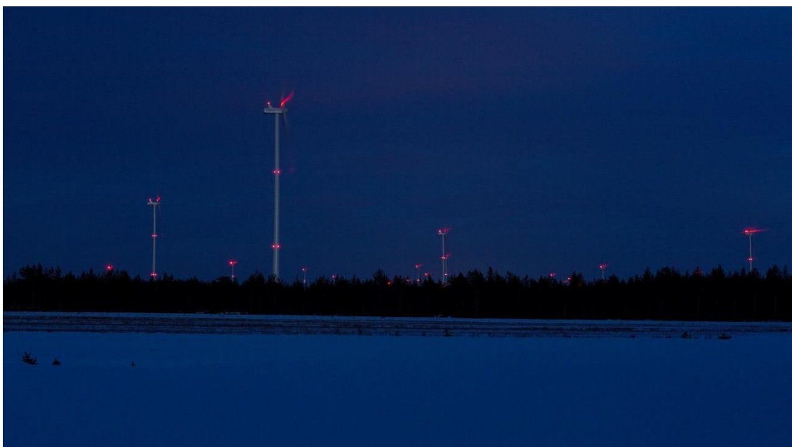
Bild 82. Fasta röda flyghinderljus (Ville Suorsa, FCG).
