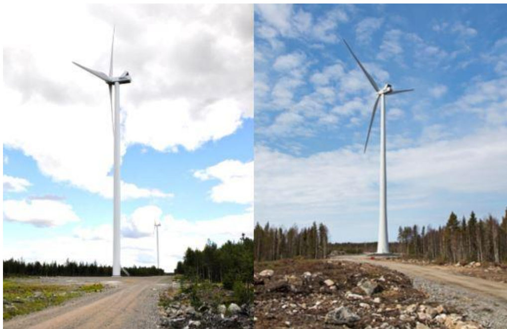
Bild 80. Till vänster ett exempel på ett cylindertorn och till höger ett hybridtorn (Leila Väyrynen och Ville Suorsa, FCG).
