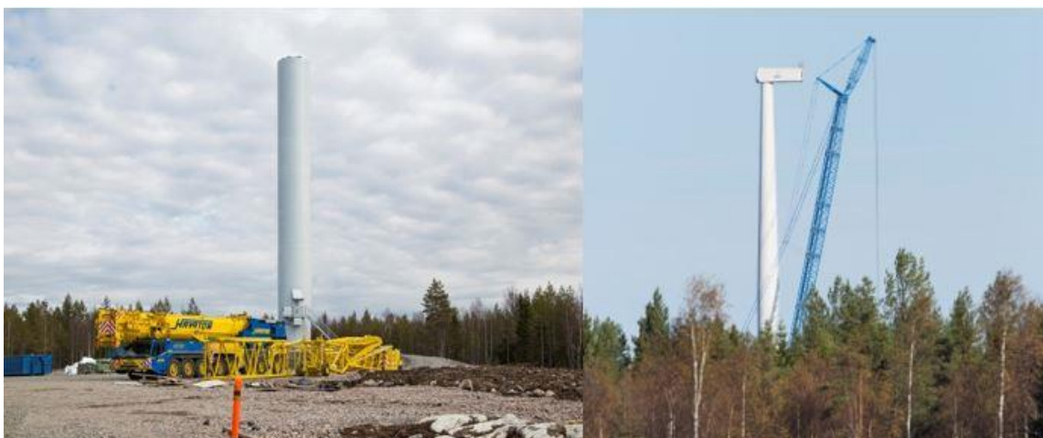
Bild 90. Montering av kraftverk (Ville Suorsa, FCG).
