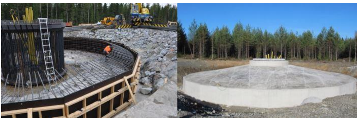
Bild 89. Byggande av grund för vindkraftverk (Leila Väyrynen, FCG).
