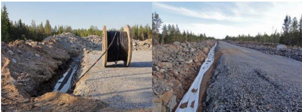
Bild 88. Jordkablarna grävs ner i anslutning till servicevägarna (Ville Suorsa, FCG).
