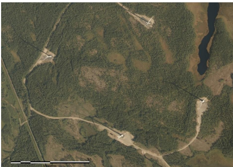
Bild 79. Exempelbild på verksam vindkraftspark. Servicevägar och resningsfält har byggts för vindkraftverken. I omgivningen av vindkraftverken och mellan dem har den tidigare markanvändningen bevarats oförändrad.
