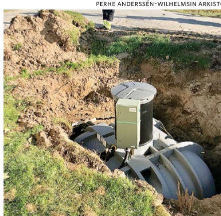
Puhdistamo kaivettuna maahan. Kaivanto täytettiin maalla ja pinta siistittiin.
